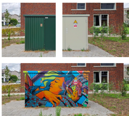
Figuur 2: voorbeelden MS/LS stations van Enexis
